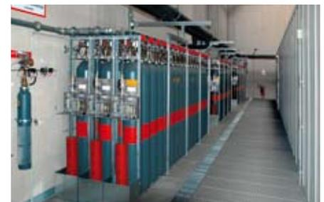
Selbst für einen Brandfall ist unser Rechenzentrum gerüstet. Mit Argongas werden die Flammen in den getrennten Brandschutzabschnitten (sog. Lampertz-Zellen) erstickt. Im Brandfall wird weiter mit Hochleistung klimatisiert, um einen Schaden durch Überhitzung sicher zu vermeiden.
